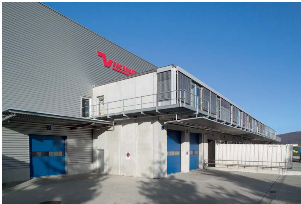
Le bâtiment Office Depot à Lenzburg.
